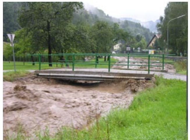
Edlitzbach bei Brücke Fasching
