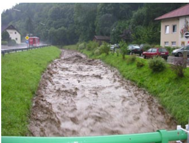
Edlitzbach bei Brücke zur Feuerwehr
